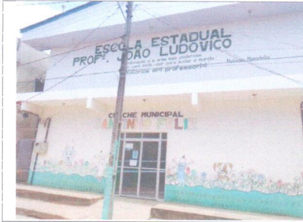
Foto: 09 - Vista Externa.
