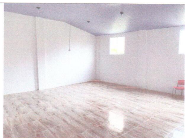
Foto: 06 - Área Reformada.
