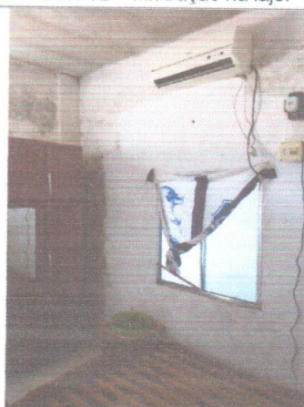
Foto: 04 – instalação elétrica exposta.
