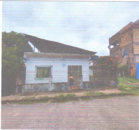
Foto: 01 – Fachada do imóvel.
