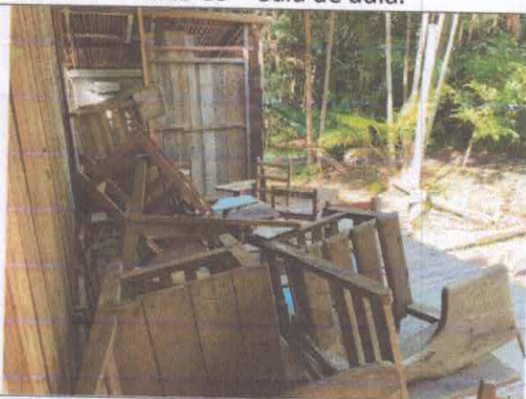
Foto 05 – Depósito e acesso ao Banheiro.
