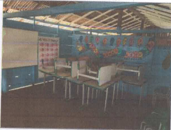
Foto 03 – Sala de aula.
