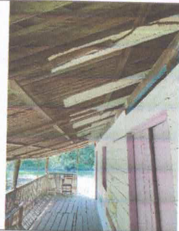
Foto 02 – Área de circulação
