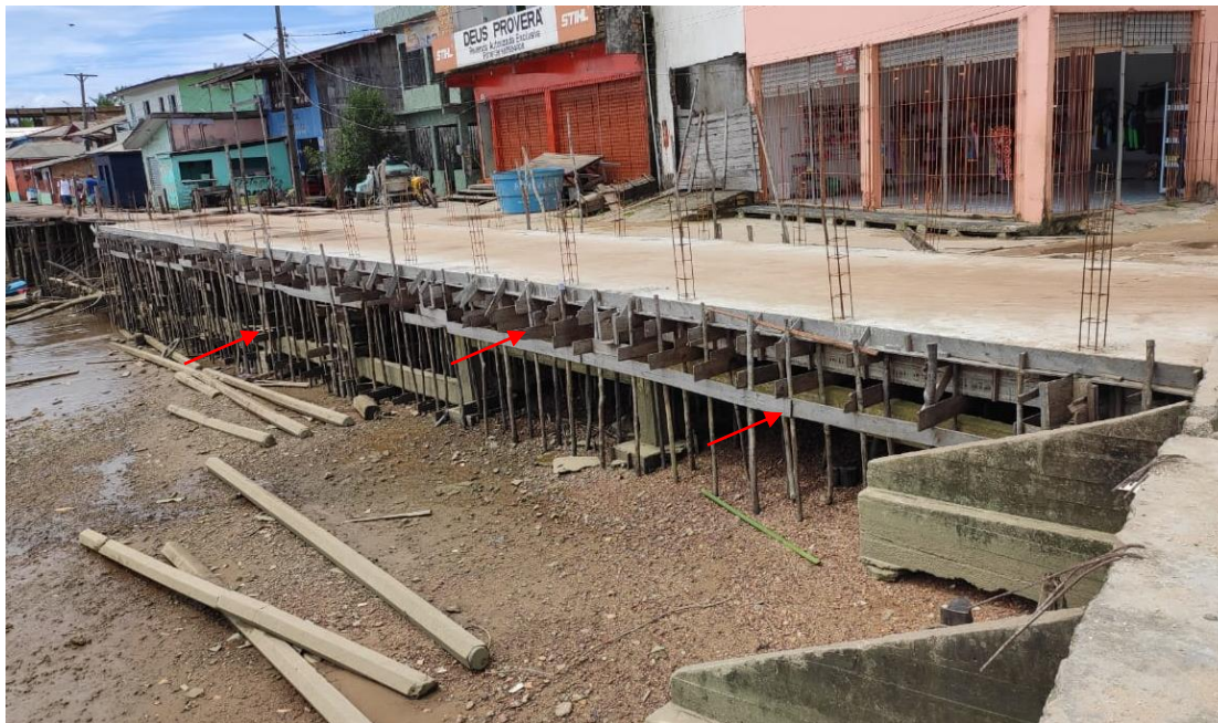
Figura 9 - Formas e escoramentos a serem retirados.
